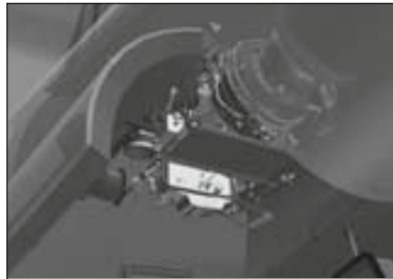
Abb. 10: Instandhaltungsarbeiten im Heck des VR-Systems A320 (Bild: FRAUNHOFER IFF)
